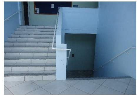
Escada de acesso - Prédio 9
