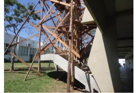
Escada coberta - Prédio 4 (em construção)
